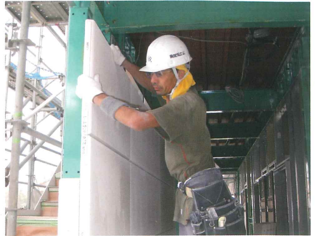
外壁ALC施工
