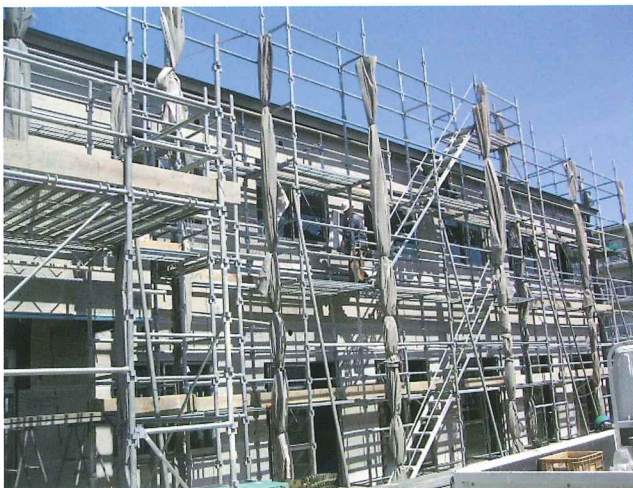
外壁デラクリート工事
