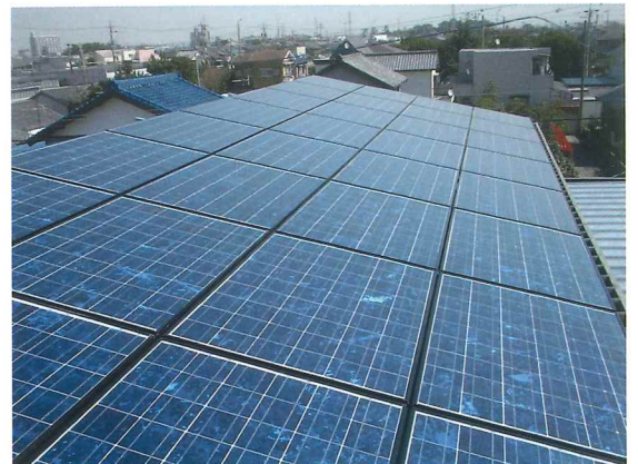
住宅用太陽光発電システム設置工事
