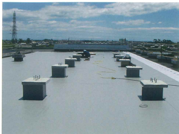
シート防水（塩ビ）工事
