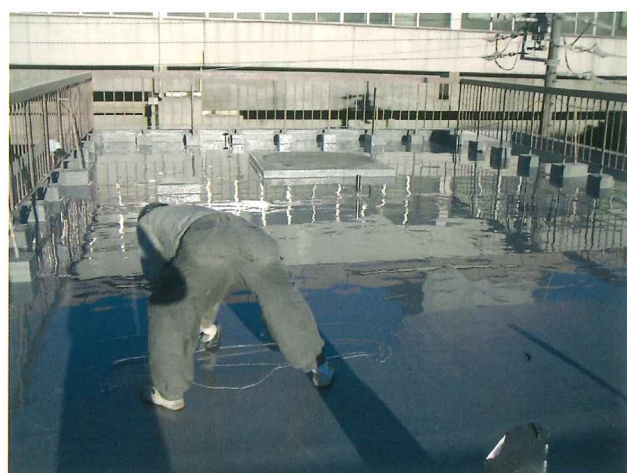
塗膜（ウレタン）防水施工
