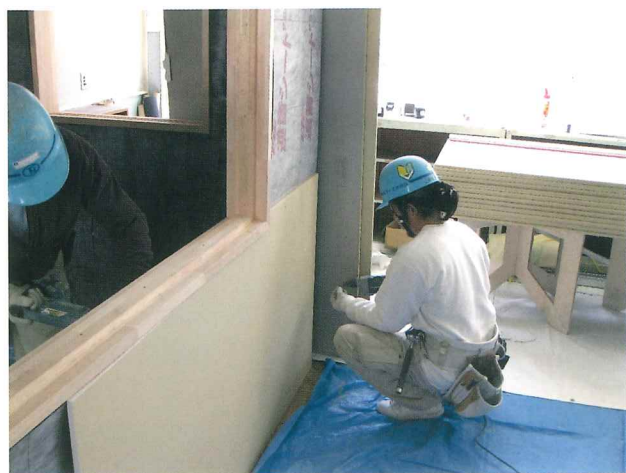
内壁石膏ボード貼施工
