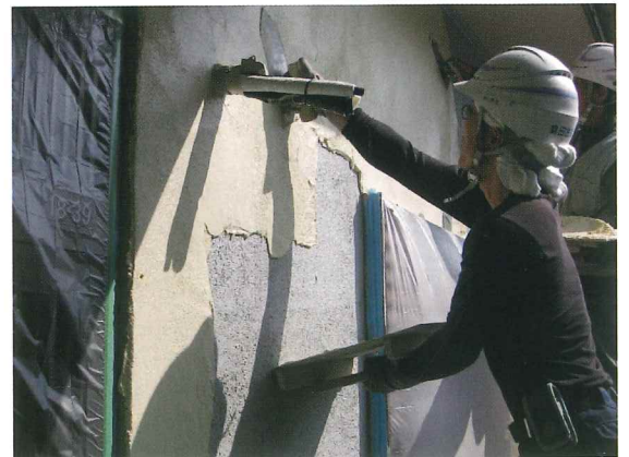
ジョリパット外壁塗替施工
