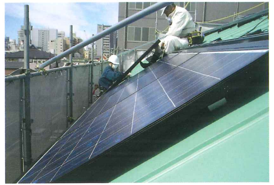
太陽光発電設置施工（セキノキャッチ工法）
