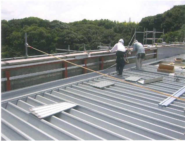
屋根板金工事
