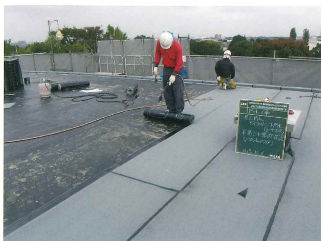
アスファルト防水施工
