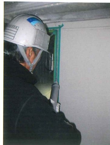
シーリング防水施工
