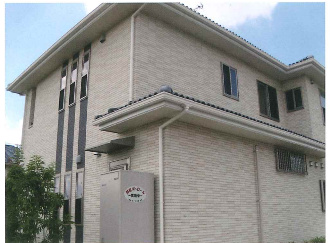
外壁 サイディング工事
