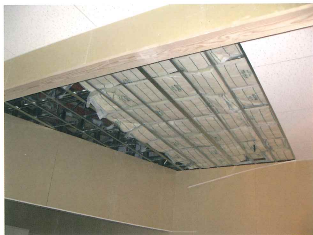
断熱グラスウール工事
