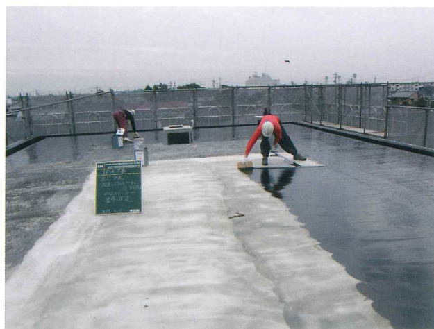
下地プライマー塗施工
