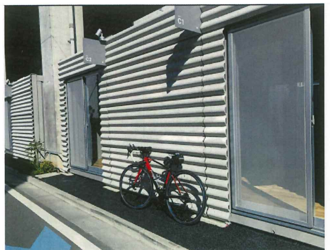
外壁 波型スレート工事
