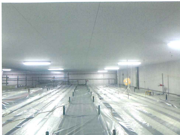
天井仕上工事
