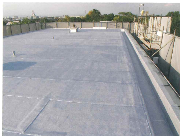
シート防水（加流ゴム系シート）工事
